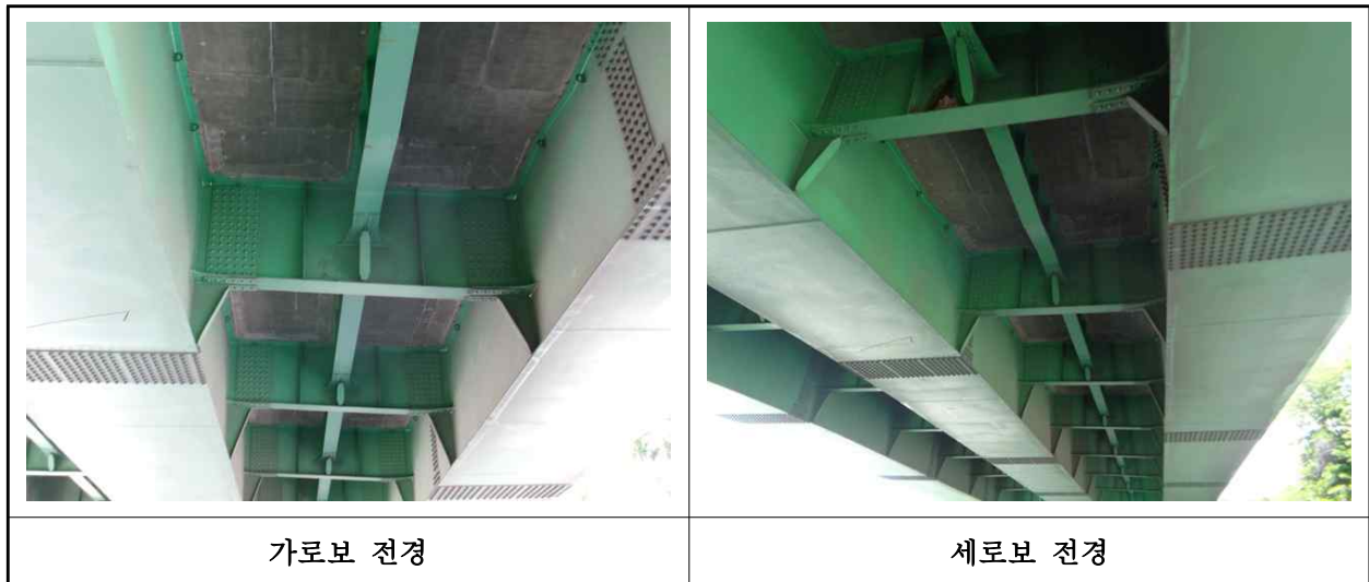
【사진 5.3.6】 가로보 및 세로보 전경
