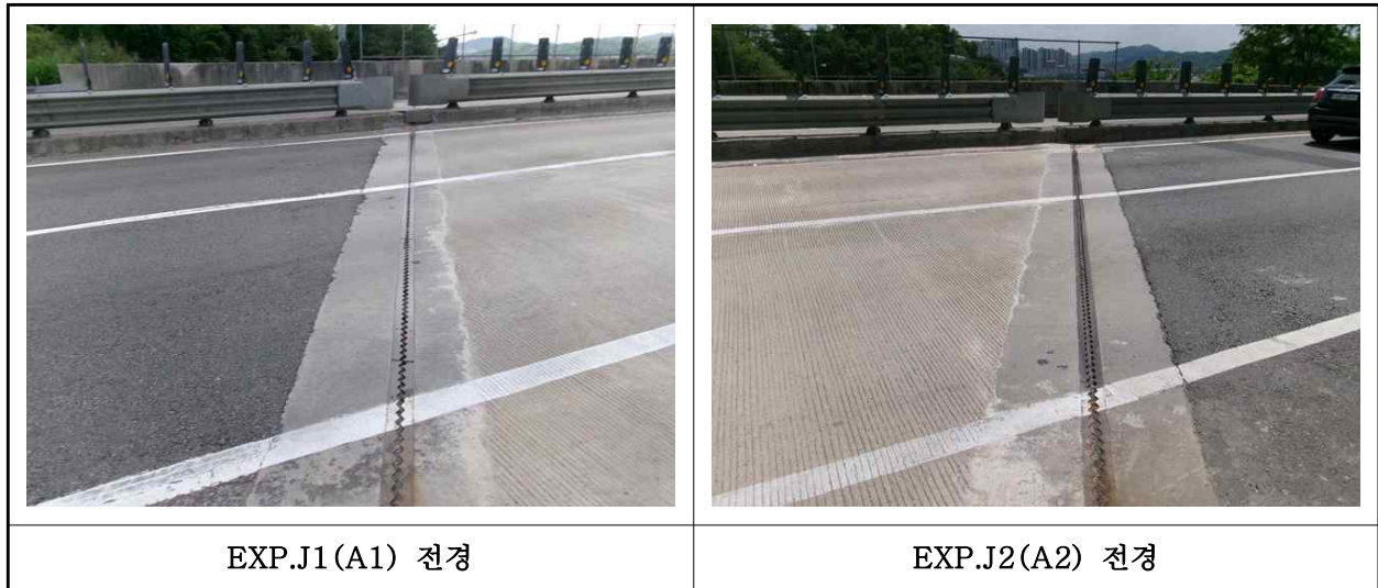
【사진 5.3.14】 신축이음장치 전경
