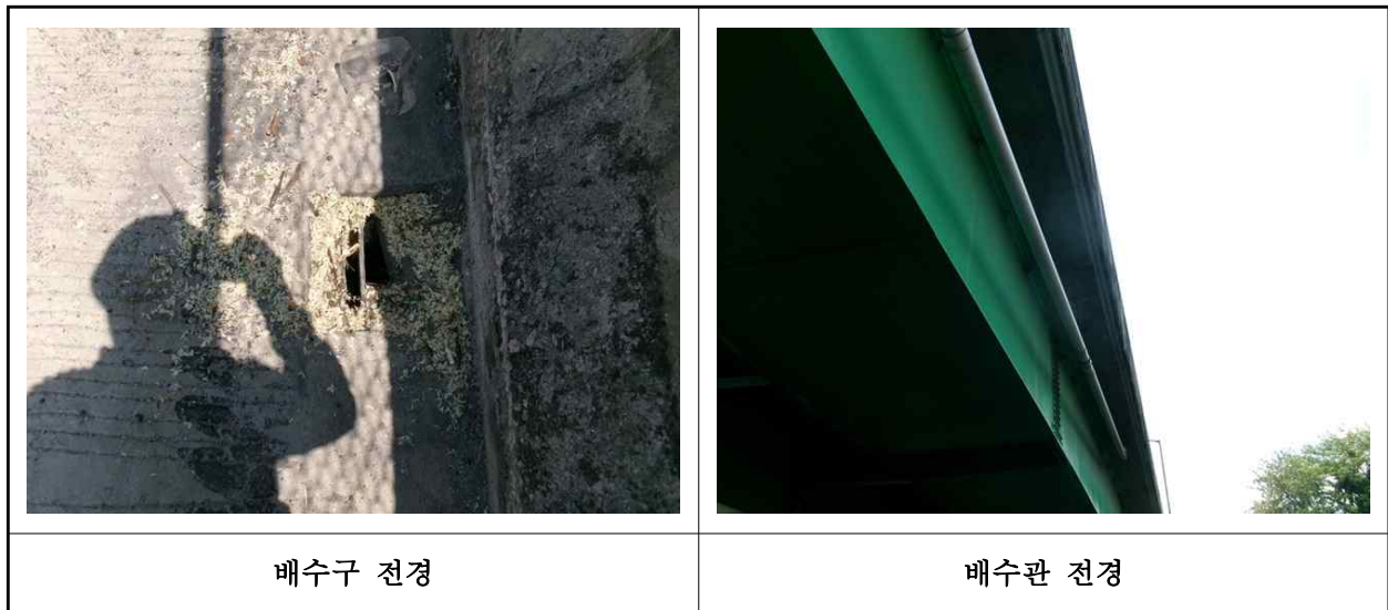
【사진 5.3.19】 배수시설 전경
