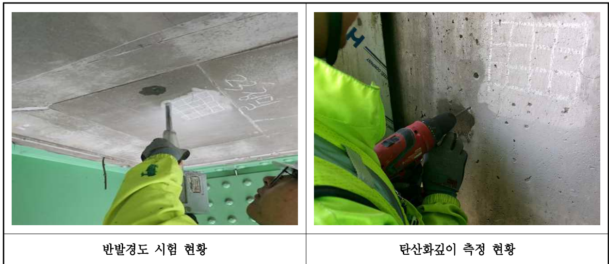
【사진 5.4.1】 콘크리트 내구성조사 현황
