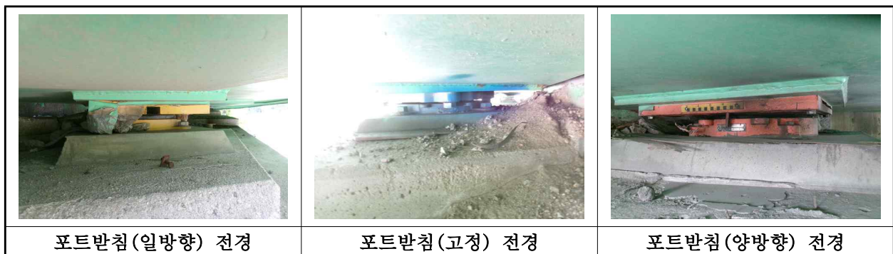
【사진 5.3.10】 교량받침 전경
