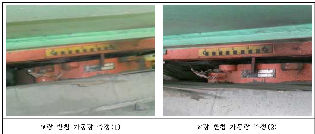
【사진 5.3.13】교량받침 이동량 측정
