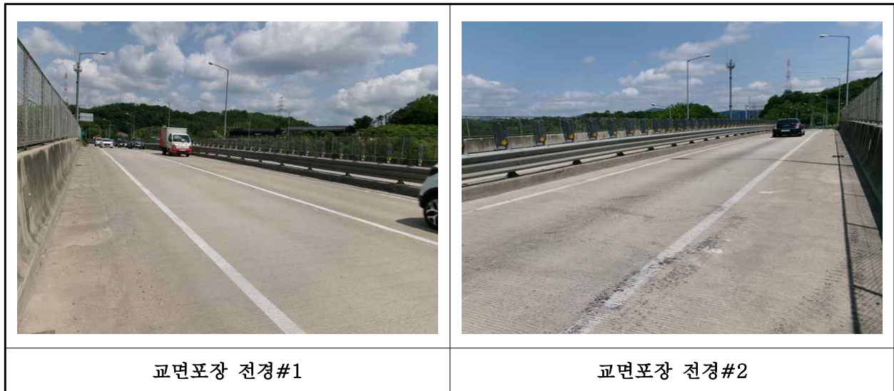
【사진 5.3.17】 교면포장 전경
