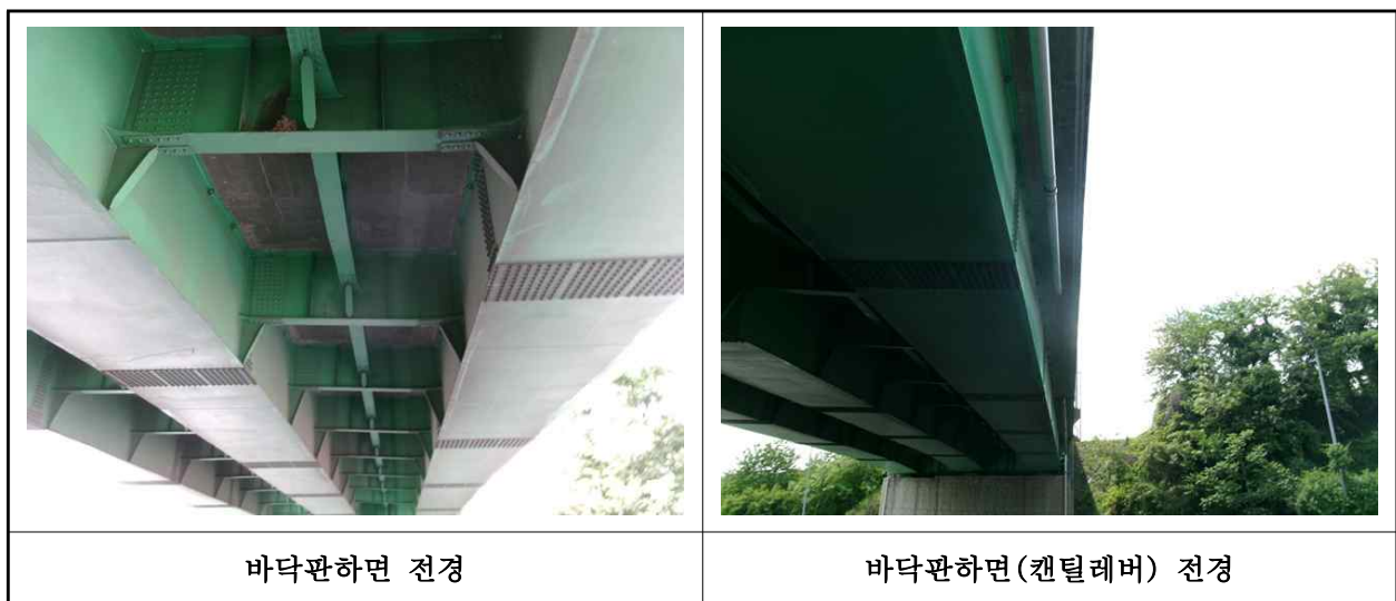
【사진 5.3.2】 바닥판하면 전경
