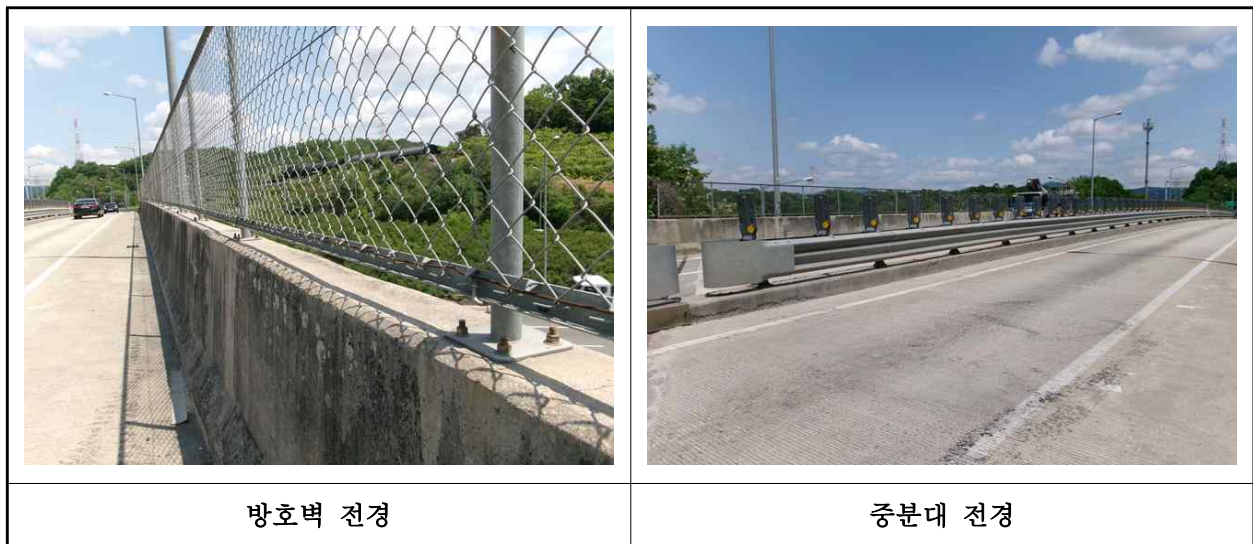
【사진 5.3.21】 방호벽 및 중앙분리대 전경
